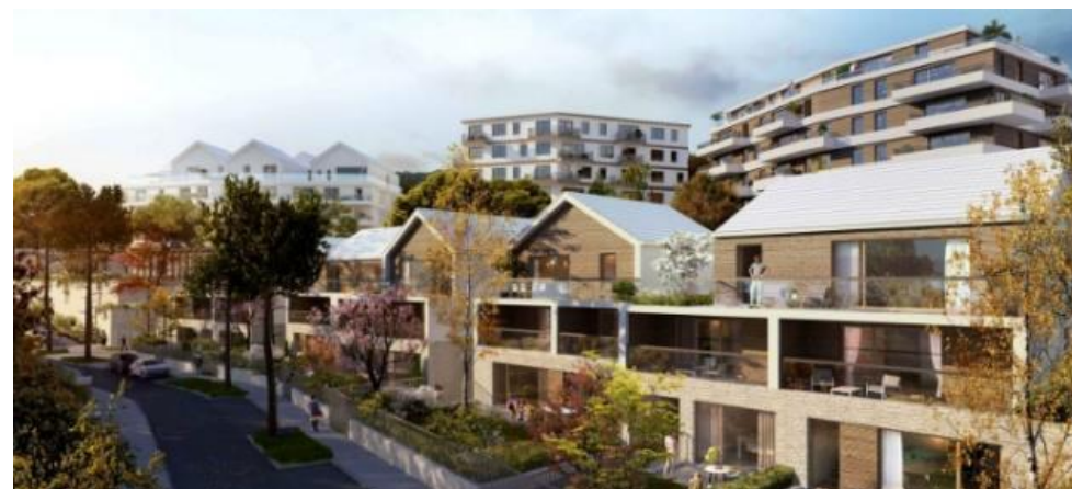
LA ZAC DES YEBLES DE CHANGIS : CHACUNE DES OPERATIONS S'INSCRIT DANS LES MODES CONSTRUCTIFS LOCAUX (GABARITS, IMPLANTATIONS, MATERIAUX...).
