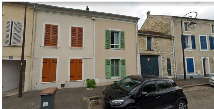
Alignement d'anciennes maison rurales, rue de la République à Avon : la densité et la modestie du bâti ainsi que le maintien de certains marqueurs (porte charretière surmontée de sa fenêtre gerbière) participent à la préservation d'une ambiance rurale en cœur d'agglomération.
