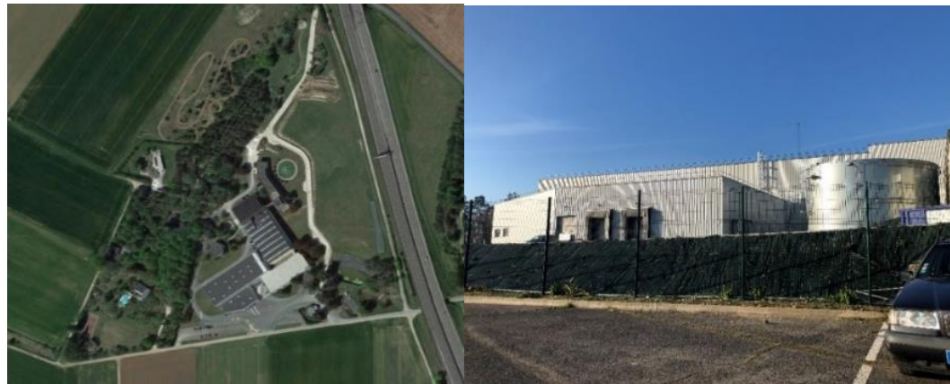
PHOTOS 1 : L'ENTREPRISE LALIQUE BEAUTY SERVICES, SITUÉE SUR LA COMMUNE D'URY - SOURCE PHOTO : GOOGLE MAPS (A GAUCHE) ET CITADIA (A DROITE)
