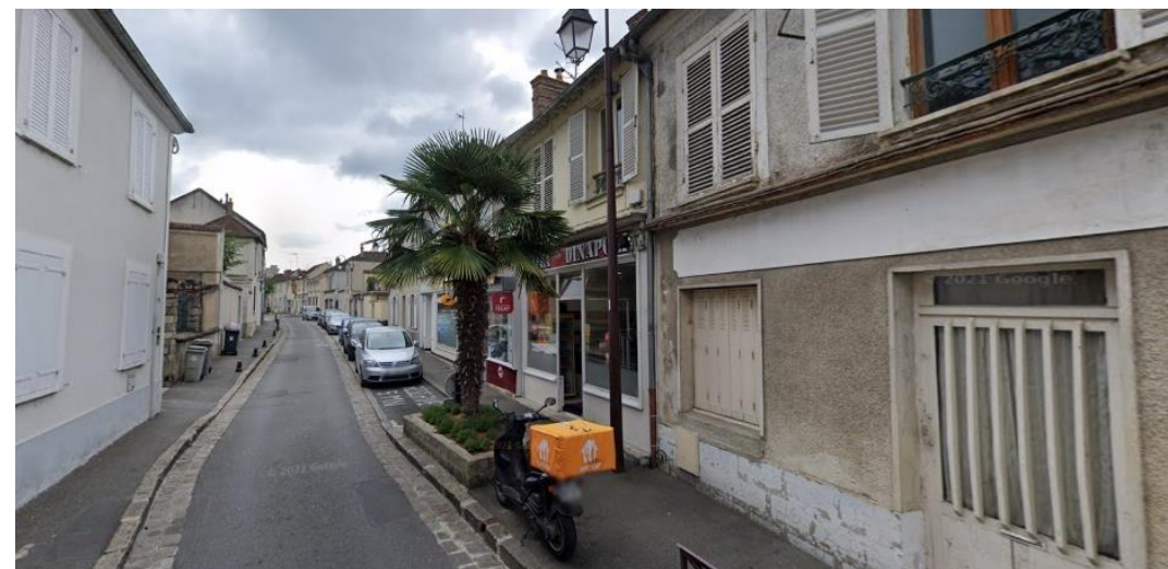
LA RUE REMY-DUMONCEL A AVON : UNE AMBIANCE DE CENTRE-BOURG AVEC SES ALIGNEMENTS HETEROCLITES D'ANCIENNES MAISONS RURALES, MAISONS DE BOURG, MAISONS A BOUTIQUE ET PETITES VILLAS
