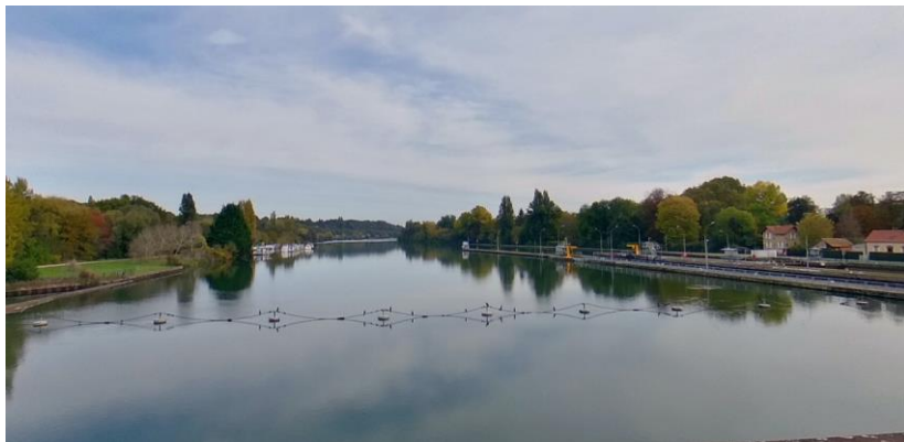
LES BERGES DEPUIS LE BARRAGE DE LA CAVE, ILLUSTRANT LA RELATIVE ARTIFICIALISATION DES BERGES NECESSAIRE A L'OCCUPATION HUMAINE (GOOGLE MAPS)
