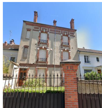
MAISON EN BRIQUES A FONTAINEBLEAU (GOOGLE MAPS)
