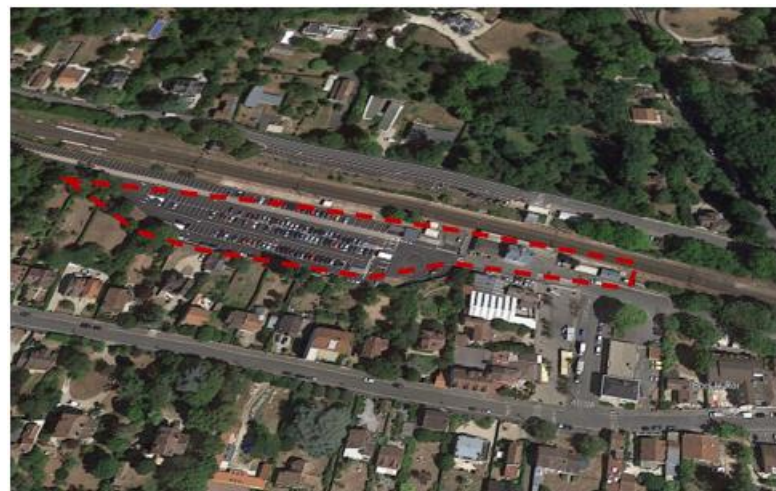
VUE AERIEENNE DE LA GARE DE BOIS-LE-ROI, METTANT EN EVIDENCE LA FORTE PRESENCE DE LA VOITURE ET L'ASPECT MINERAL DE CELLE-CI (GOOGLE MAPS)
