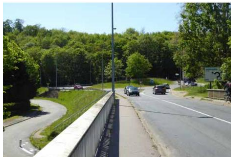
FIGURE 33 : ARRIVÉE PAR LE PONT SUR LA SEINE DEPUIS SAMOREAU
