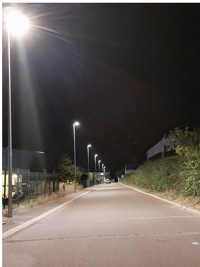
Rénovation luminaires ZAE Samoreau 1
