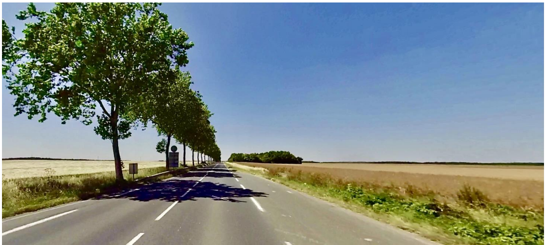
Vue depuis la RD 152 vers l'Ouest : vue très large uniquement cantonnées par les lisières lointaines au Nord et au Sud. Importance de la plantation d'alignement qui donne sa signature visuelle au site (Source : ©Google Street View, 2023)
