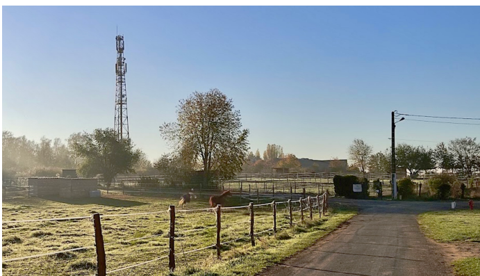
Vue du site vers le Sud-Est et les grand volumes de bâtiments de la zone d'activité
