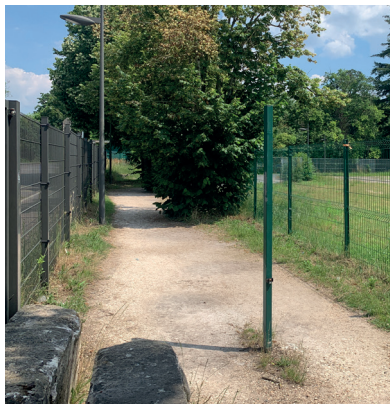
CLÔTURES DE PART ET D'AUTRE DU CHEMINEMENT PIÉTON
