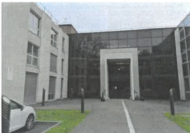
7 Lots travaux pour les futurs locaux
