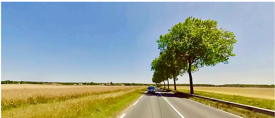
Vue depuis la RD 152 vers l'Est : la vue selon l'axe de la voie se referme plus rapidement, barrée par les lisières qui ponctuent les vallées sèches qui se poursuivent au Sud de la RD (Source : ©Google Street View, 2023)
