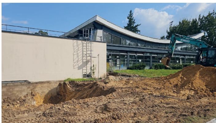
Extension pour les locaux techniques
