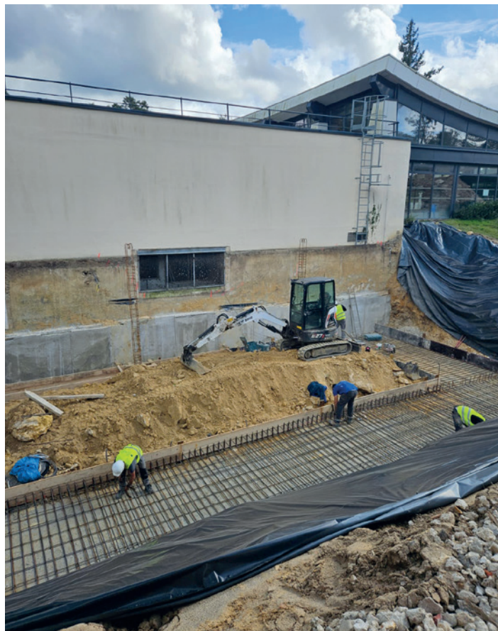
Fondation pour la future machinerie
