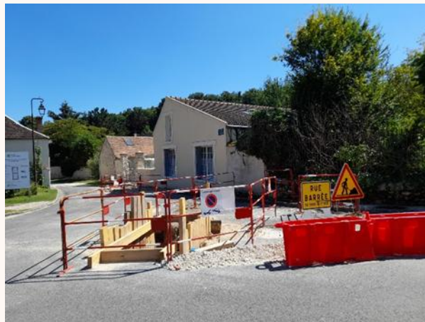
Figure 17: Travaux à Boissy-aux-Cailles
