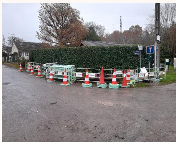
Figure 18: Travaux à Héricy
