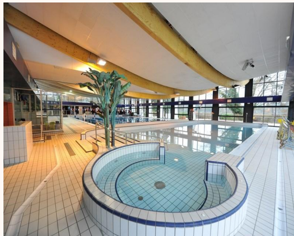
Figure 31: Piscine de la Faisanderie
