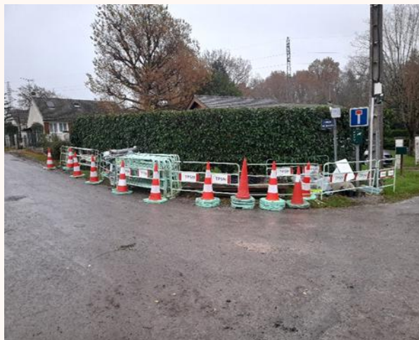
Figure 18: Travaux à Héricy
