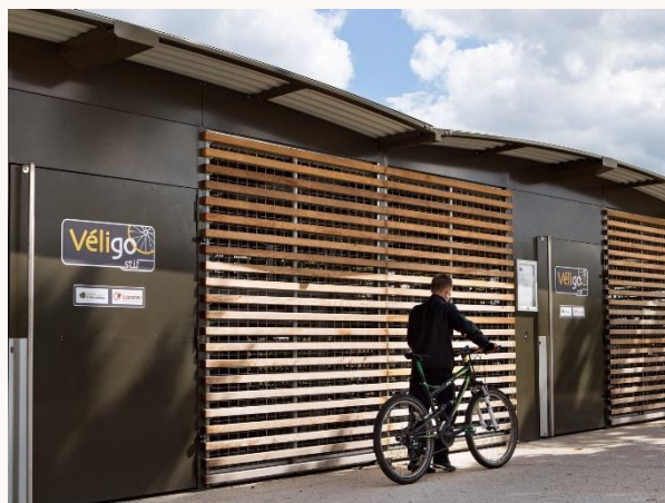
Figure 28: Abri vélos en gare de Fontainebleau-Avon
